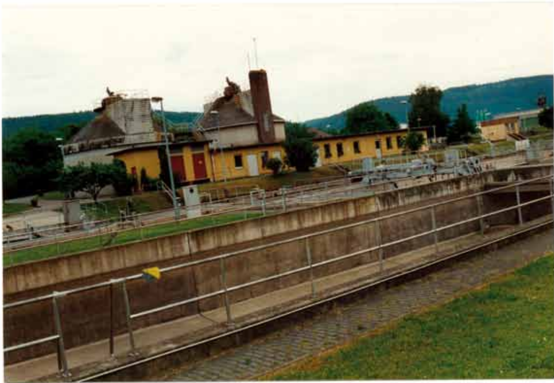
Bild der Zentralkläranlage Wertheim
